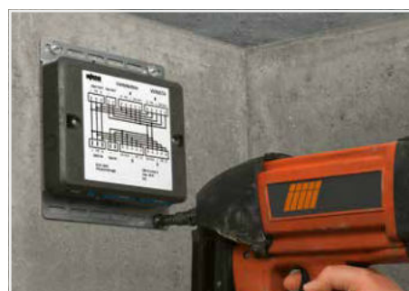
Montageplatte mit montierter WINSTA®-Box an der Wand befestigen (z. B. mit Bolzenschubgerät).
