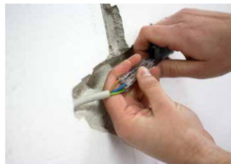
Leitung mit Leitungsreparaturset verbinden.
