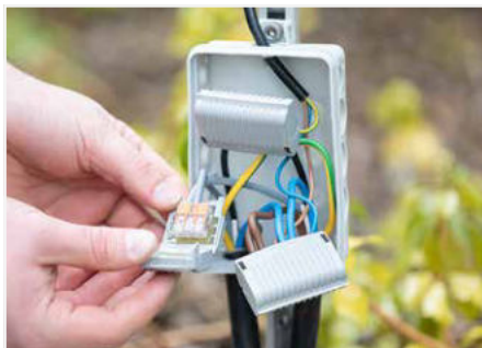
Anschluss einer Pollerleuchte
