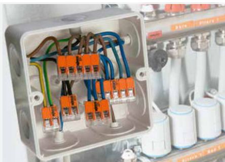
Verdrahtung feindrähtiger Leiter in Installationsdosen bei Fußbodenheizung
