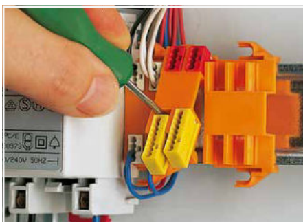
Befestigungsadapter aus dem Verband lösen.
