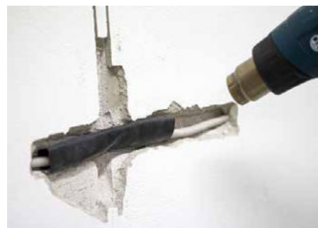
Schrumpfschlauch erhitzen und Schadstelle wieder fachgerecht verschließen.
