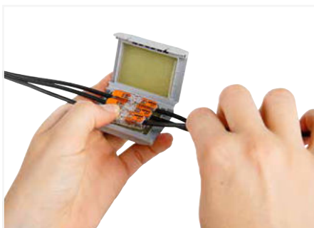
Verdrahtete Klemme in Gelbox einlegen.
