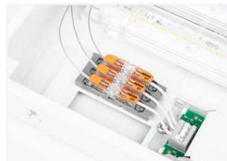
Mehrpole, lagefixierte Verdrahtung einer Leuchte
