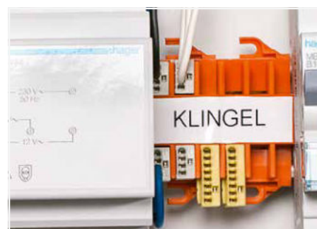
Anwendung für eine Hausklingelanlage – Befestigung auf Tragschiene 35
