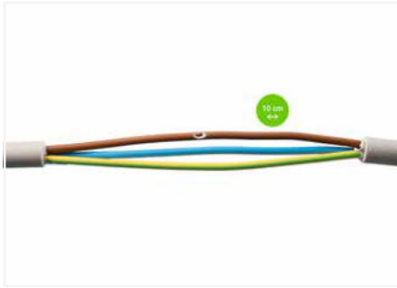
Beschädigte Leitung ca. 10 cm symmetrisch um die Schadstelle herum abmanteln.
