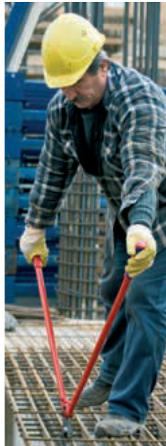
Die besondere Kopfform des Mattenschneiders ermöglicht das Schneiden flachliegender Baustähle
